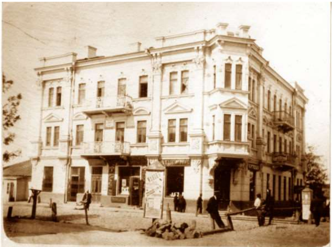
8. Будинок по вул. Олександрівській (сучасна вул. Проскурівська, 13). Фото поч. XX ст.
