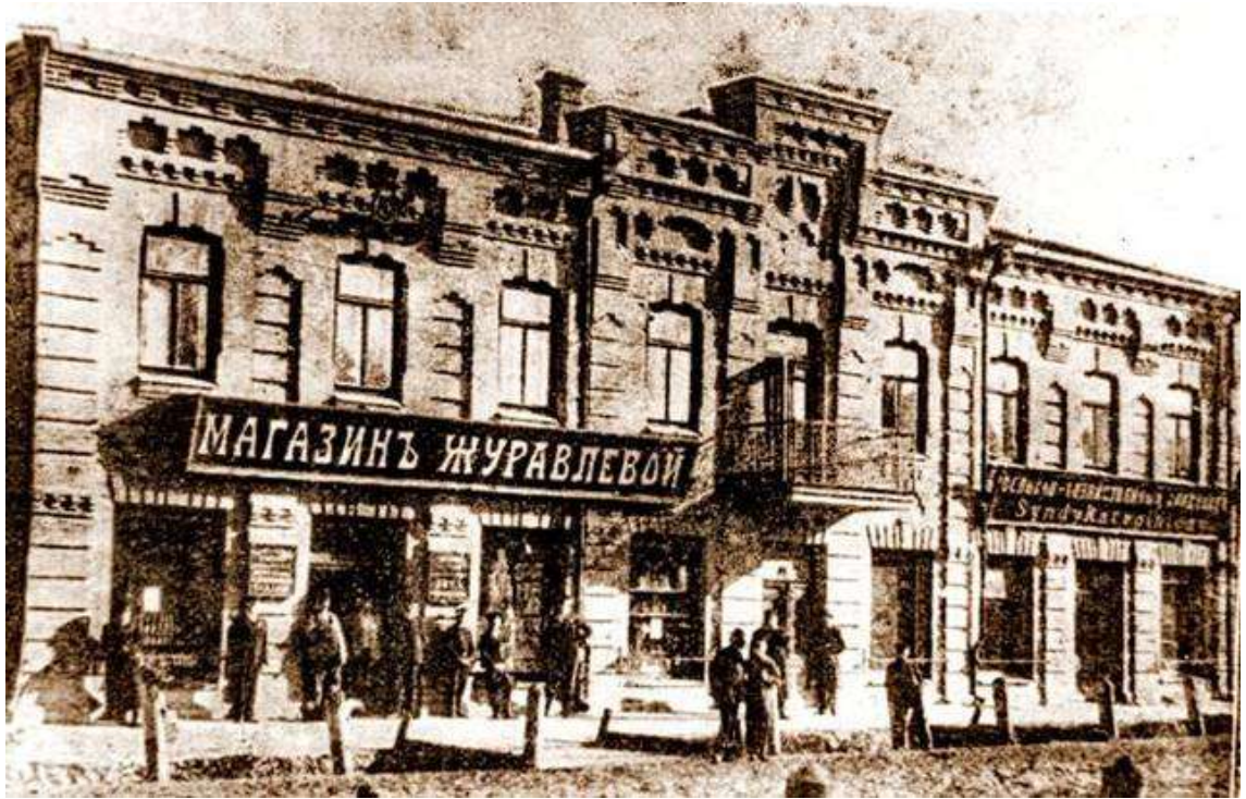
7. Будинок по вул. Олександрівській (сучасна вул. Проскурівська, 7). Фото поч. XX ст.
