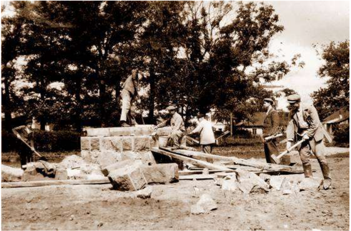
51. Будівництво меморіалу пам'яті в Піонерському сквері. Фото кін. 1950-х рр.
