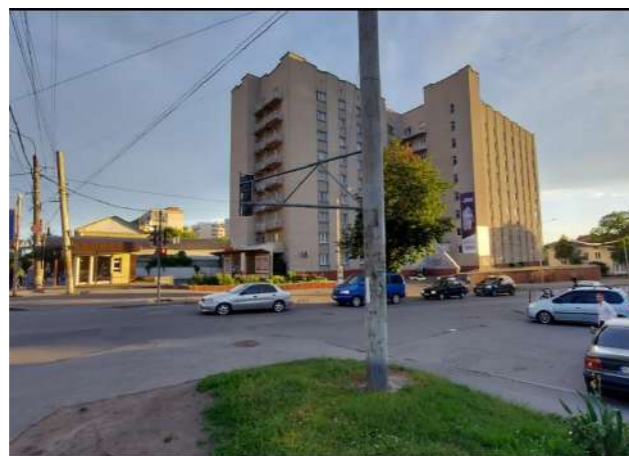
Фасад будівлі по вулиці Кам'янецька, 12
