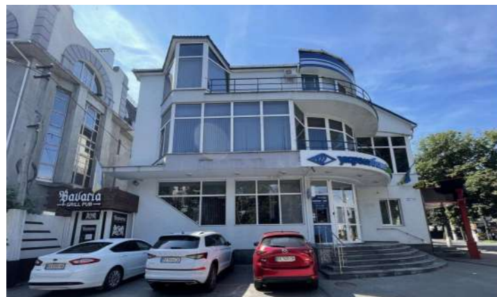
Фасад будівлі по вулиці Кам'янецька, 49/1
